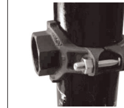
6. Montaj tamamlandı Assembly completed
