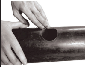
1. Boru hazırlığı Pipe preparation
