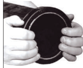
3. Conta montajı Gasket installation
