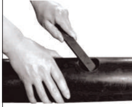
2. Çapakları temizleyin Remove burrs
