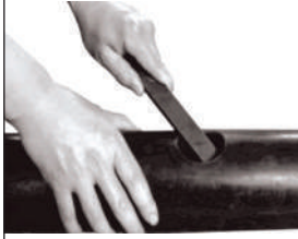
2. Çapakları temizleyin Remove burrs
