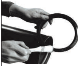
2. Contayı yağlayın Lubricate gasket
